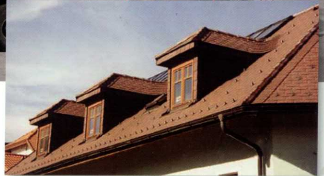
Eternit Doppeldeckung mit gestutzten Ecken belvedere, Dachgaube komplett verkleidet, Ichsens rund ausgebildet und eingebunden, beidseitige Rollschal mit Sattelkappen
