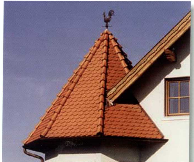
Rundschnitt Biber Doppeldeckung, Nasenfirstkappe, handgefertigter Kupferhahn, drehbar mit Wetterrichtung
